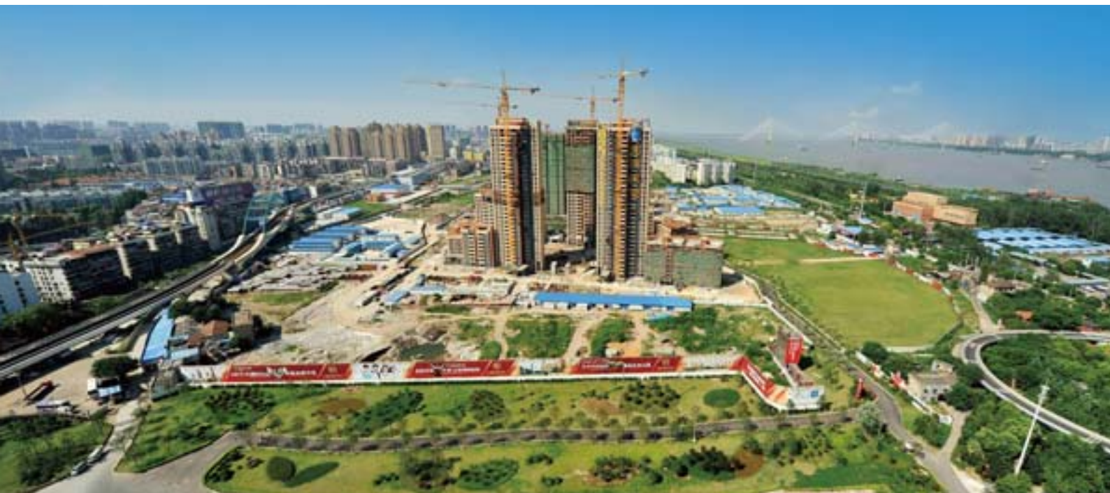
武漢天地施工現場
