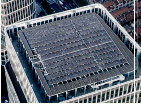
太平洋新天地T2大廈的屋頂太陽能光伏
