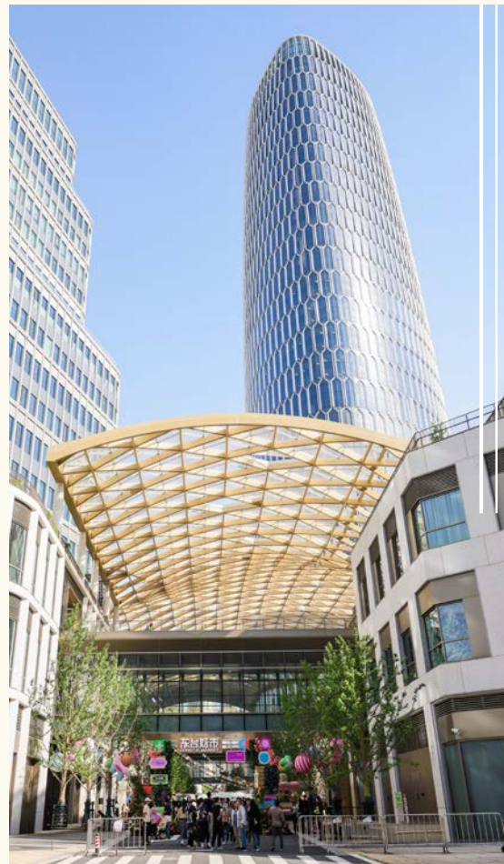
新天地东台里和太平洋新天地T1大厦
