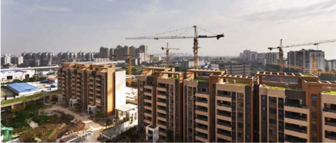
◀ 正在建設中的武漢天地
