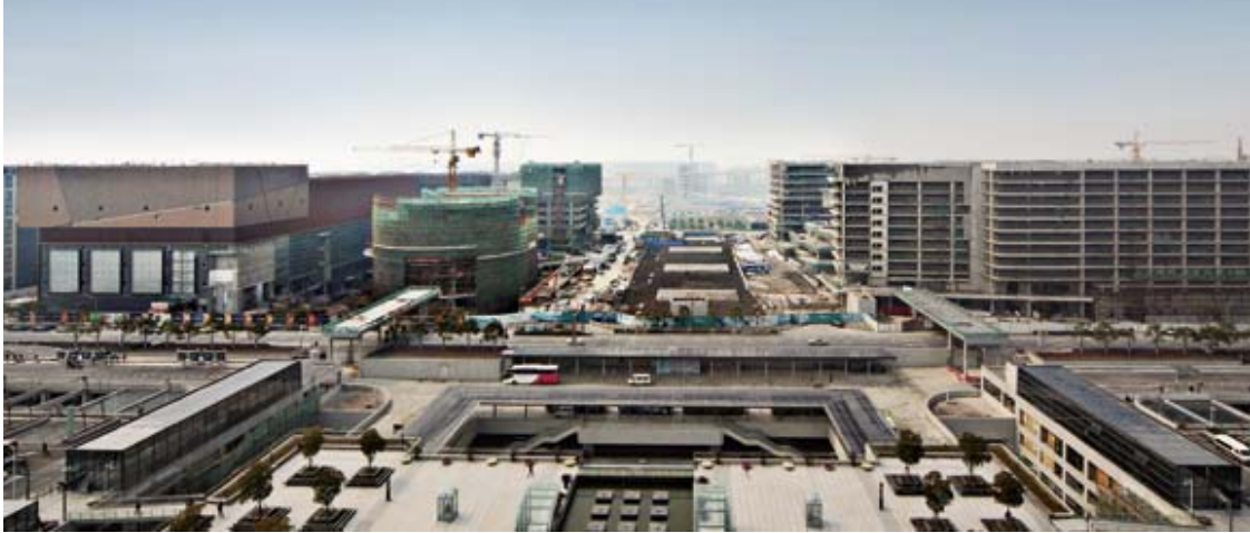
◀ 正在建設中的 虹橋天地
