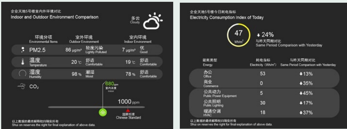
企业天地电梯显示屏持续披露楼宇内 PM2.5 等环境数据
