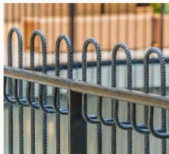
由回收钢筋制成的栏杆
